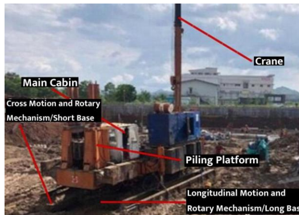
Gambar 2 HSPD pada Proyek Yogya Kota Baru Parahyangan
