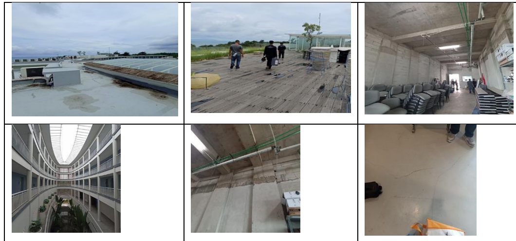
Gambar 4.1 Dokumentasi Bangunan Pemeriksaan Visual
